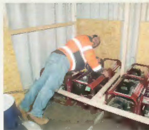
Rob PA2R bezig met het vastzetten van de generatoren in de container.
